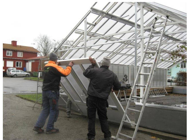
Här sätts pardörrarna på plats av växthusbyggarna.
